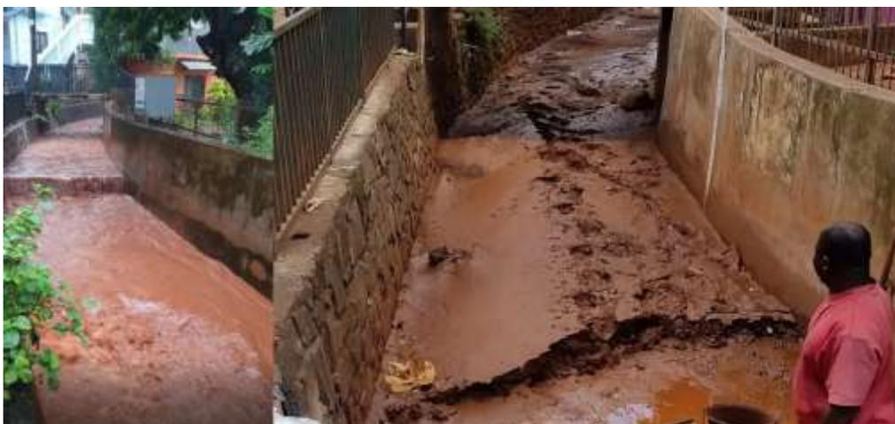
Figure 14 - Photo de l'impact de l'érosion des sols sur le réseau urbain d'eau pluviale à Mayotte (© DECTOT, BRGM/LESELAM)<sup>39</sup>
