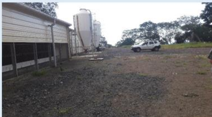
Exemple de réalisation TO 4.1.1
